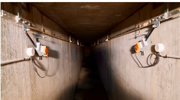
Moteur individuel par tringlerie guidée indépendamment
