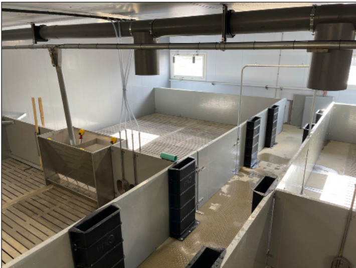
Vue d'ensemble sur salle engraissement
