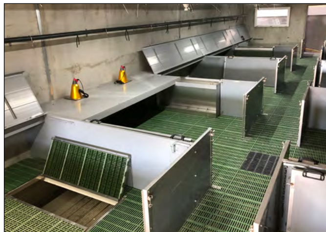
NIDS RELEVÉ & TRAPPE ACCÈS FOSSE
