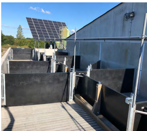
QUAI AVEC AUGES RÉSINE
