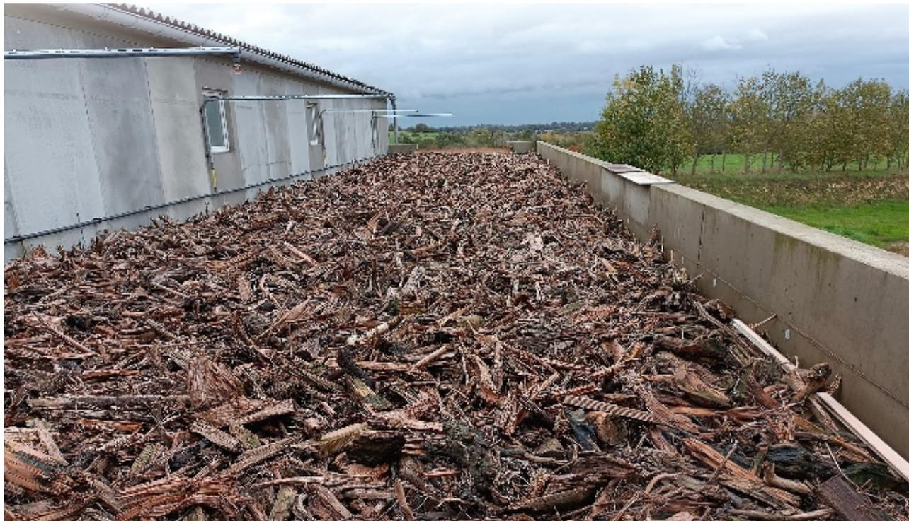
Un biofiltre bien optimisé permet de réduire plus de 50 % des émissions d'ammoniac.
